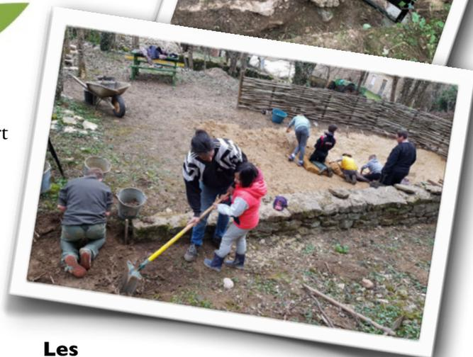
**Les étapes de la construction de la mare pédagogique : Pose de l'argile et battage, treillis de protection, aménagement des murets et de la vanne de prise d'eau**
